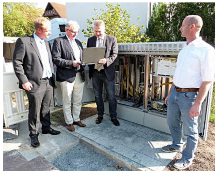
Am neuen Schaltgehäuse am Sandreuther Weg stehen von links Andreas Rudloff, Bürgermeister Günther Hübner, Friedrich Weinlein und Michael Sturm von Navitel GmbH aus Bindlach. Foto: PR
